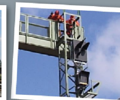
Montage der Signalkörbe
