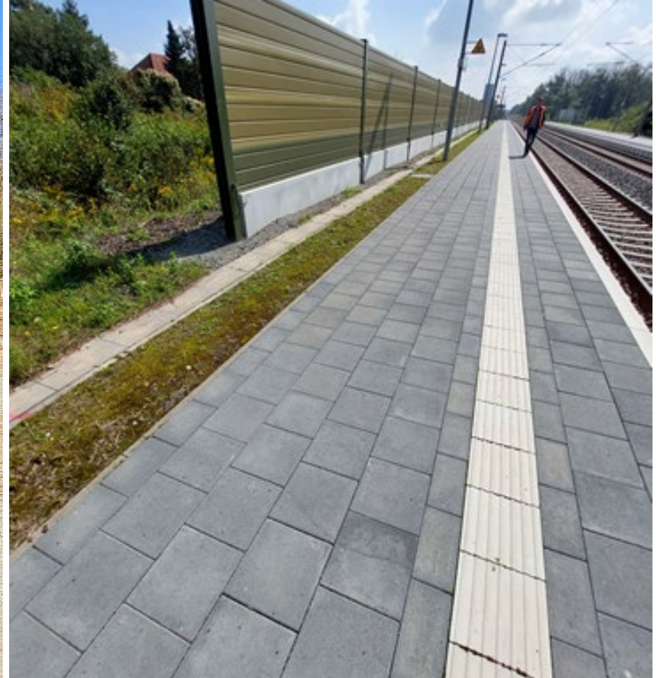
Lärmschutzwand in Deutzen
