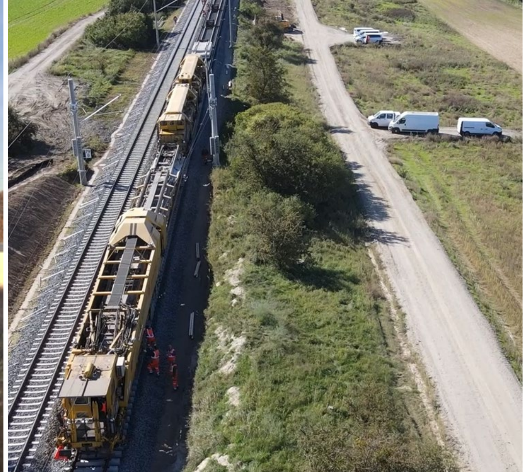
Angermünde: Fertigstellung der Gleisverlegung
