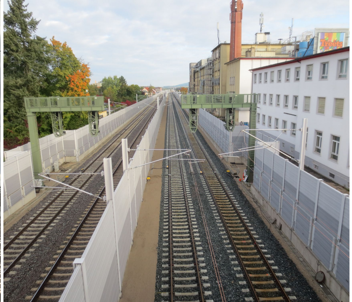
BV Forchheim: LSW am Bf Forchheim Gleis 2/3
