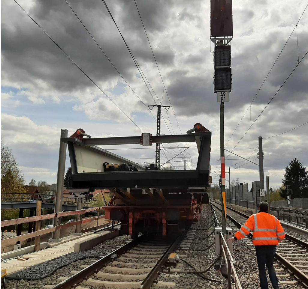
Nordkreuz-Karow, Strecke 6081 Gleis 12: Abnahme Oberleitung
