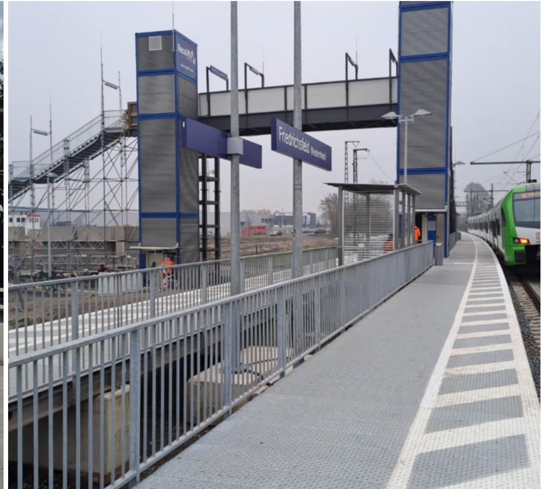
ABS 46/2 BA 3 Prof. Bf. Friedrichsfeld / Personenüberführung und Aufzüge und Fahrradabstellanlage in Betrieb
