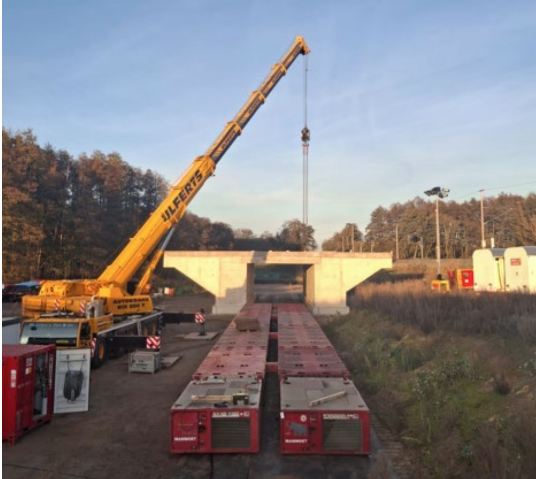
Angermünde: Vorbereitung Einfahren EÜ Welsebrücke
