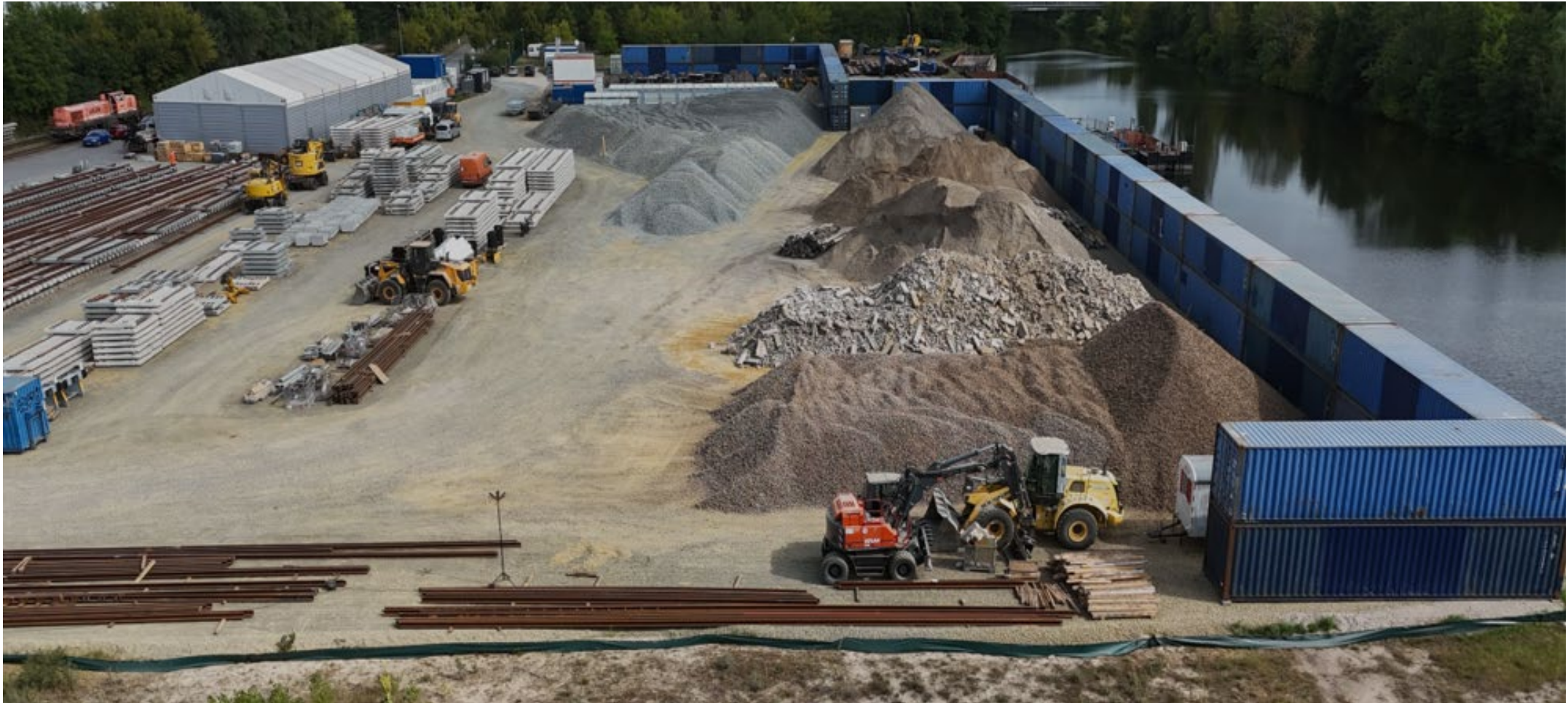
Hochleistungskorridor (HLK) Berlin-Hamburg: Baustelleneinrichtungsfläche zur Weichenvormontage
