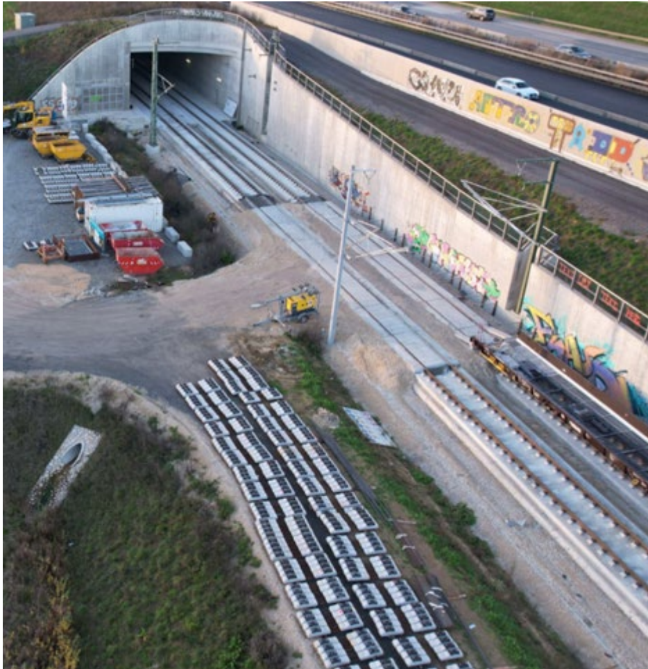
S 21 Los D: Tunnel Denkendorf / Mittenkernauffüllung Bitu der FF / Randwegprofilierung
