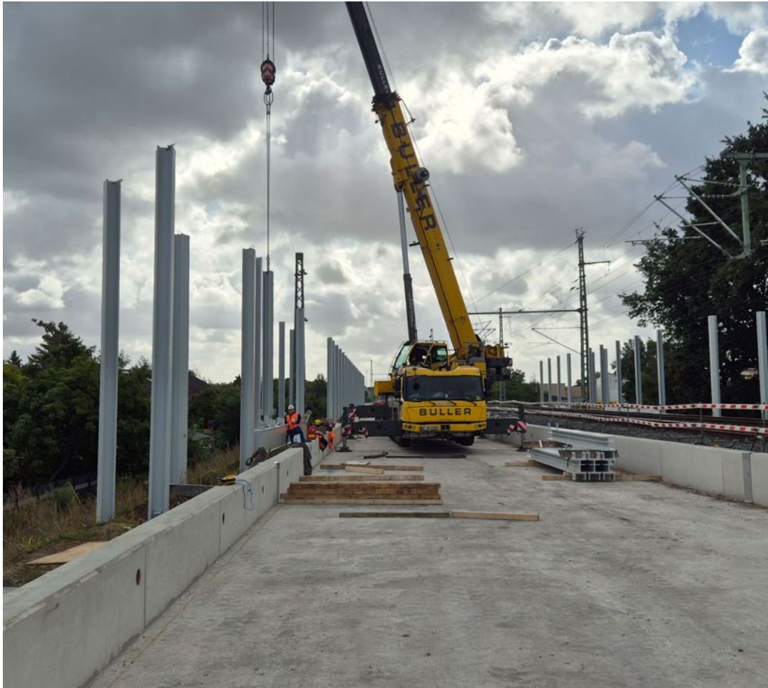
ABS 46/2 BA 2 in Dinslaken Trogbauwerk und LSW 3. Gleis / Grundschootereinbau 3. Gleis
