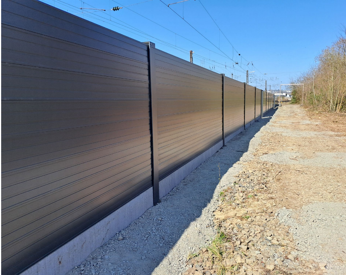
Lärmschutzwand in Lahnstein
