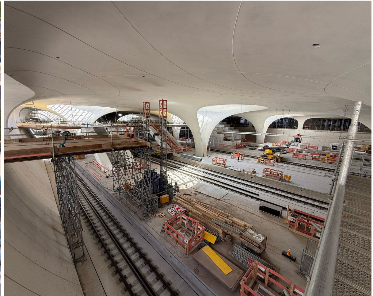
S 21 Los B: Einbau Einzelstützpunkte / Blick in die Bahnhofshalle
