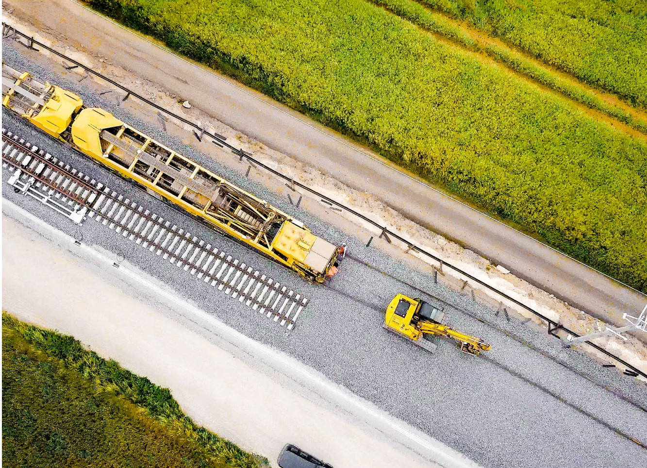
Niesky-Lohsa: Gleisneubau mit Schnellumbaumaschine SUM 314 „Mammut“
